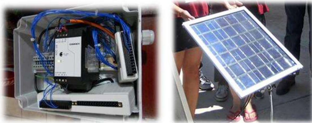
Figura 7. Fuente 24V y Panel Solar
